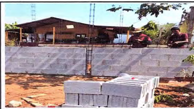
Foto 4: Construcción de muro perimetral lado izquierdo
