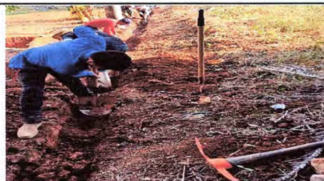
Foto 3: Construcción de muro perimetral
