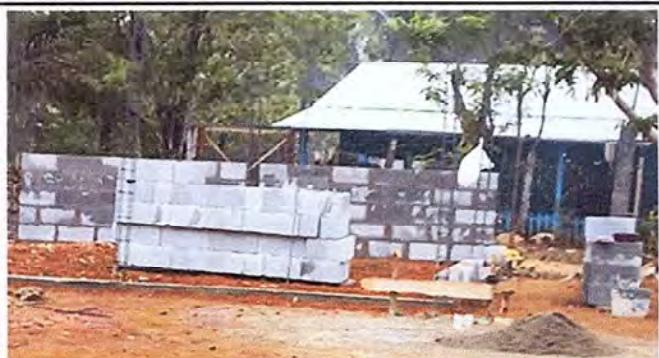
Foto1: Construcción de baño
