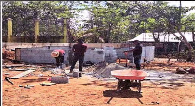
Foto 2: Construcción de Cocina
