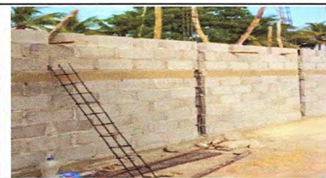
Foto 5: Construcción de muro perimetral lado derecho
